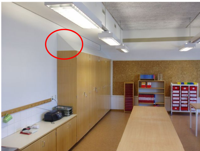
Figur 2: Visar del i ett av de klassrum som åtgärdats. Av fotot framgår att faktorer som påverkar rummets hygieniska förhållanden beaktas, exempelvis att översida skåp sneddställs.
