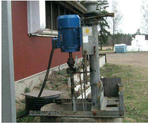
Bild 6. Pumpen i pumpbrunnen bör vara eldriven. Att pumpa med traktor innebär högre energianvändning. Det kan också behövas en eldriven omrörare som kompletterar pumpen.
