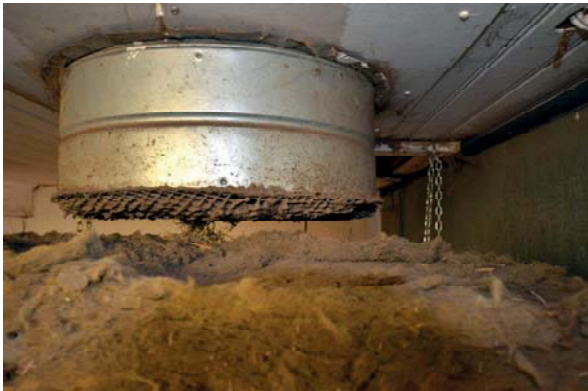
Bild 29. Kraftigt ökade strömningsförluster p.g.a. nedsmutsade galler och skräp framför öppning.
