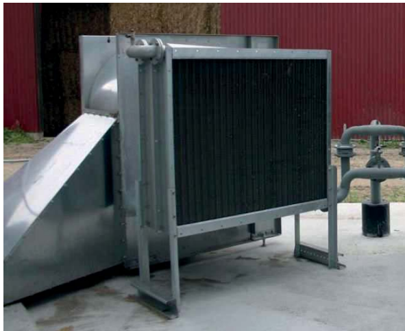
Bild 47. Tillsatsvärme till silotorken. Här värms torkluften med ett varmvattenbatteri anslutet till en biobränslepanna.
