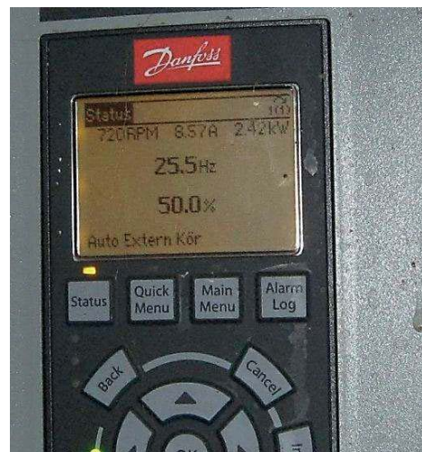
Bild 16. Frekvensomformare används här till en vakuumpump. På displayen ser man aktuell frekvens och effektuttag.
