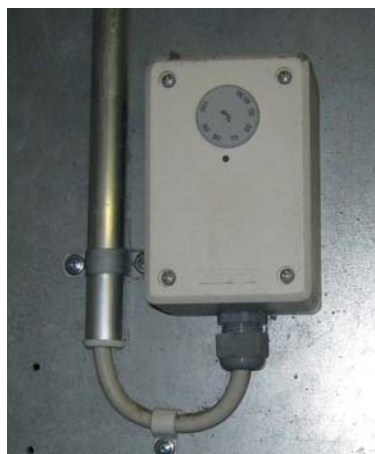
Bild 45. På hygrostaten ställer man in vid vilken relativa luftfuktighet som fläkten ska gå.
