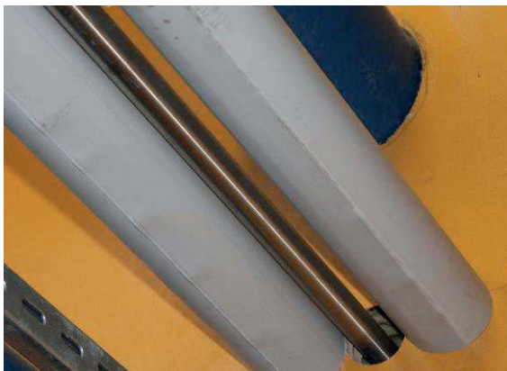
Bild 22. Mjölkkledningen från roboten till tankrummet har isolerats.
