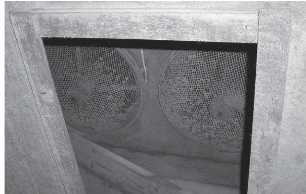
Bild 30. Nedsmutsade skyddsgaller som stryper luftflödet och ökar energiförbrukningen.
