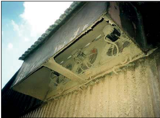
Bild 31. Trång huv framför utblås ger onödig strypning.
