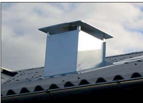
Bild 32. Platsbyggd takhuv med vassa kanter och trångt utlopp som stryper luftströmmen.
