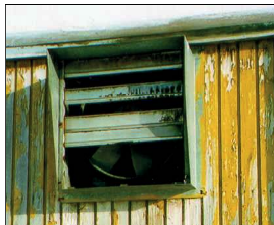
Bild 33. Fastrostat och trasigt jalousispjäll ger onödiga strömningsförluster.
