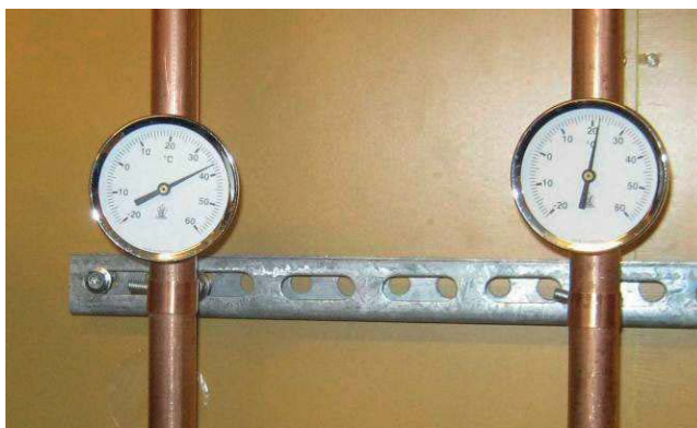
Bild 19. Rören till och från värmeväxlaren bör ha termometrar - en billig investering. Det hade sett bättre ut om rören dessutom var isolerade.
