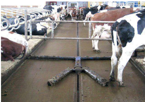
Bild 4. Utgödslingen i mjölklagårdar görs med skrapade gångar eller med skrapor under spalt. Med rätt förutsättningar kan man under spalten ha självflyt, gödseln flyter ut till tvärkulvert av sig själv.
