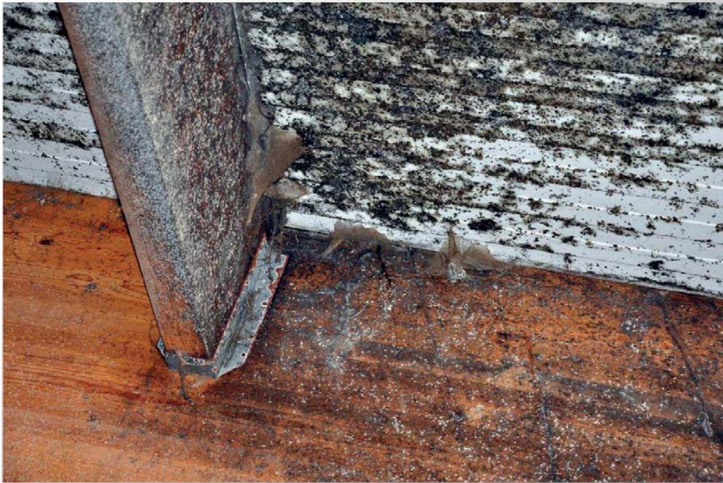
Bild 2. Mögel, rost och röta i taket på 6 år gammalt stall orsakat av otillräcklig ventilation och värmeförlust.
