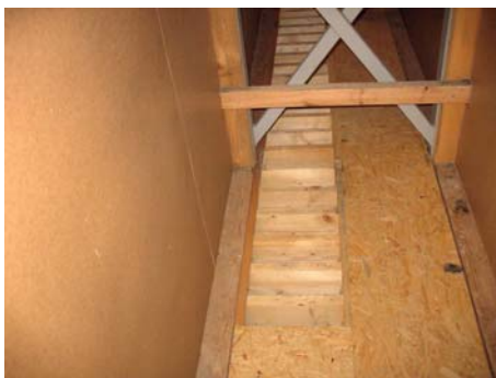
Bild 44. Alla skarvar i luftfördelningsystemet ska tätas. Bild inifrån huvudkanalen till en östgötatork.
