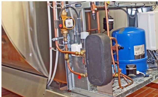
Bild 18. I värmeväxlaren, här isolerad med svart skumplast, växlas värme över från kylkretsen till vatten. Även ledningarna ska isoleras.
