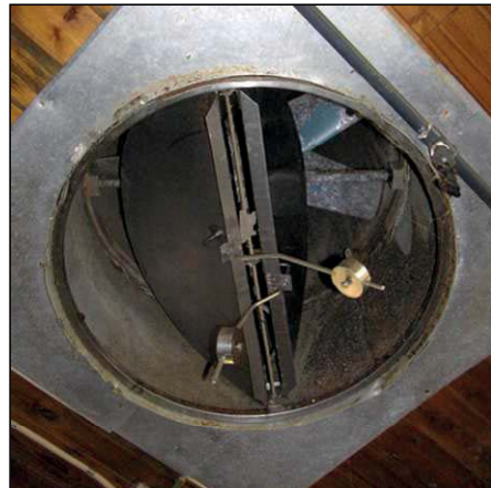
Bild 32. Vippspjäll på stegfläkt skall antingen vara helt stängt eller helt öppet. Detta spjäll har fastnat i ett mellanläge och ger onödigt motstånd.
