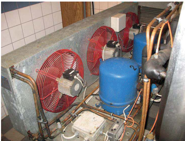
Bild 7. Del av kylaggregat med dubbla kompressorer (inneslutna i blå höljen). Tanken skymtar till höger och till vänster finns kondensorpaketet med tre kylfläktar. I detta fall har kondensorpaketet placerats i direkt anslutning till tanken och man ser inget som tyder på att det är särskilt välventilerat.
